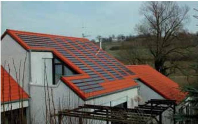
Viele innovative Projekte wurden über die Jahre hinweg realisiert: Eines der ersten Projekte 1988 war das **Solarhaus Ensheim**. Zukunftsweisend wurde ein Haus solaroptimiert gebaut und das Dach auf die solare Nutzung mit einer Photovoltaikanlage ausgerichtet.
