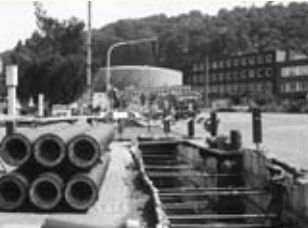
6.5.1966 – Bauarbeiten in der Mainzer Straße
