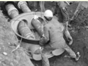
13.11.1973 – Bauarbeiten am Eternitschacht in der Erfurter Straße
